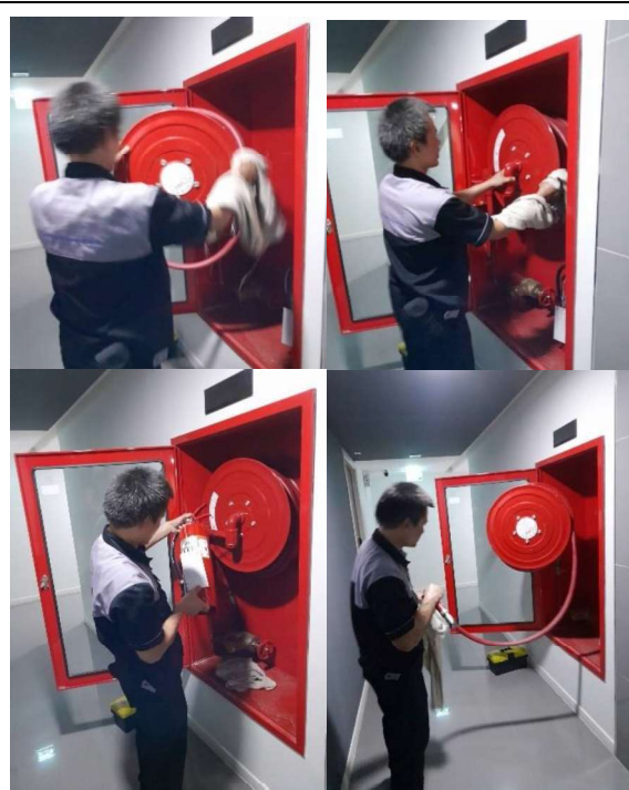
ภาคผนวกที่ 3.36 การตรวจสอบตู้เก็บสายดับเพลิง
