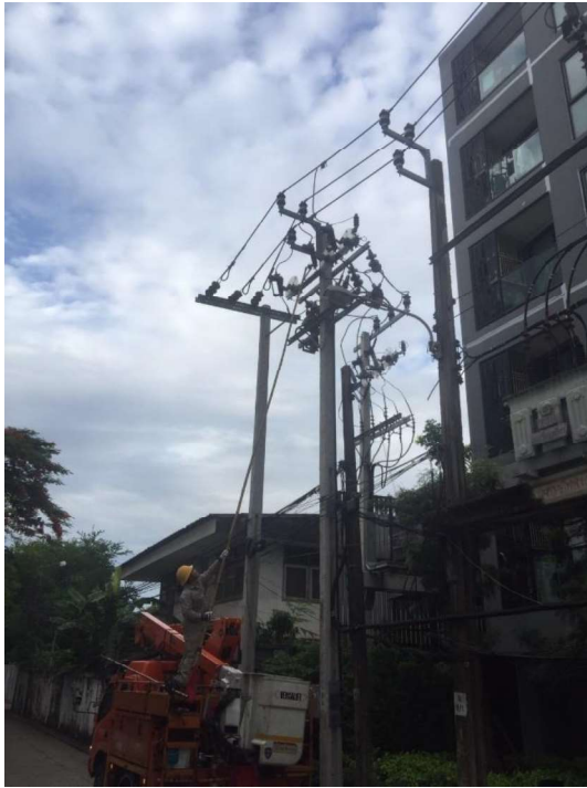
ภาคผนวกที่ 3.33 การซ่อมบำรุงหม้อแปลงไฟฟ้า
