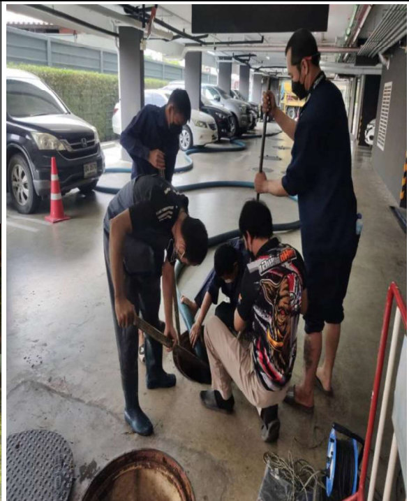
ภาคผนวกที่ 3.10 การตรวจสอบสภาพบ่อพักระบบ น้ำบาดน้ำเสีย
