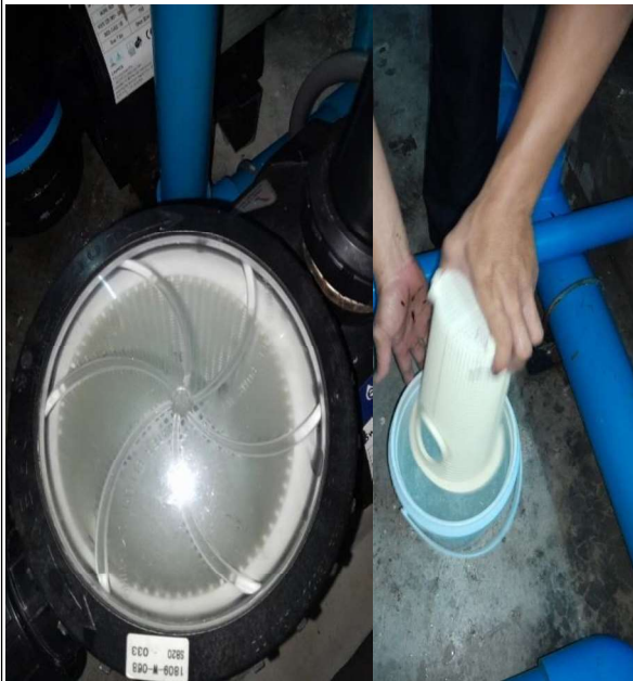
ภาคผนวกที่ 3.29 การทำความสะอาดระบบกรองสระน้ำ
